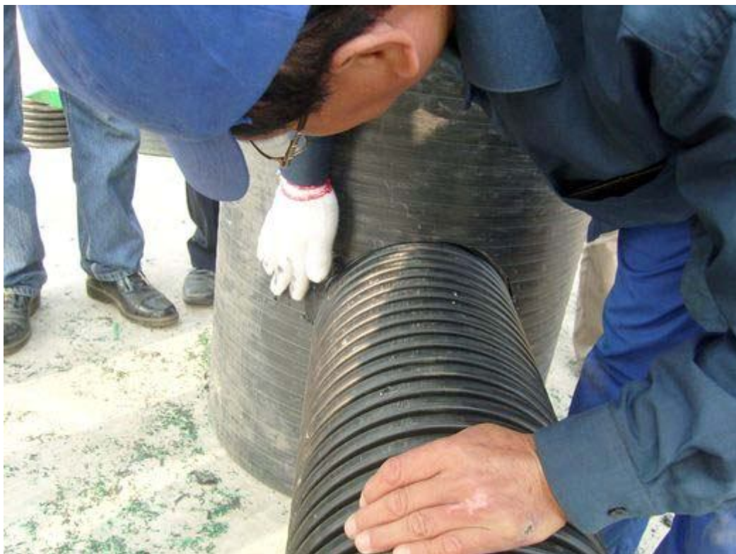
Gia công hố ga HDPE Ø800 mm
